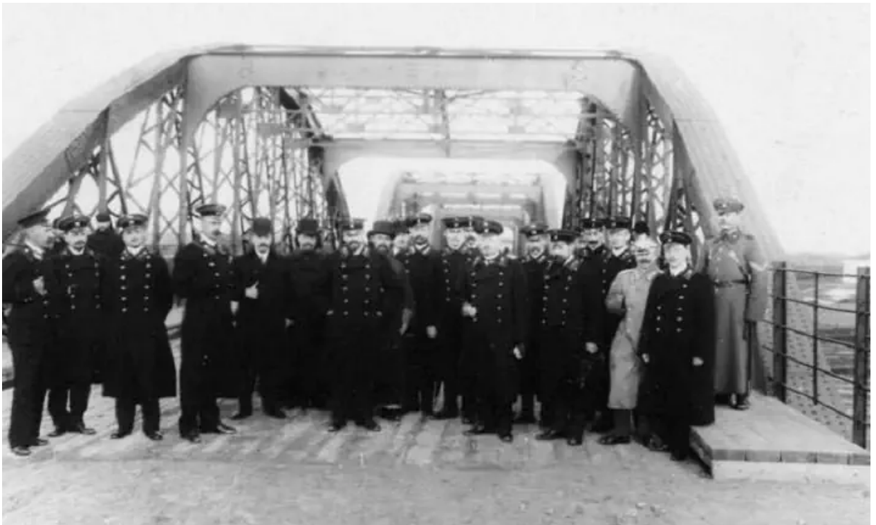
Группа служащих Министерства путей сообщения у стальных конструкций моста на станции «Фарфоровский пост». (Путепровод на 6 версте лит. Ж.). Автор съемки: Ателье К. Буллы. Дата съемки: до 1914 г. ЦГАКФФД СПб. Е 9157.
